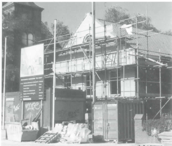
De restauratie van de voormalige schuilkerk 'De Hoop' aan de Hartveldseweg is in volle gang (foto Jaap Haag, december 1997).
