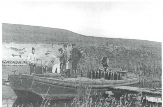
De aanvoer van granaten voor de kanonnen die op 'Fort Diemer-dam' waren opgesteld geschiedde met dekschuiten die door de Kleislout vaarden. Tijdens zijn bezoek aan Diemer-dam in 1893 was Olie hier getuige van.
