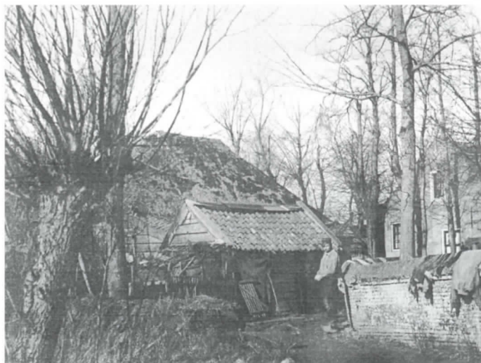
Een bijzondere foto die Jacob Olie in 1891 in Oud-Diemen maakte. Links de achterzijde van het perceel Ouddielerlaan 164 met schuurtje. Rechts is nog net een stukje van de oude bakstenen muur van kerkhof 'Gedenk te Sterven' te zien. In het pand rechts op de achtergrond was tot 1806 het 'schoolhuis' van de Nederlands hervormde kerk gevestigd. Op deze plaats (Ouddielerlaan 170) bevindt zich thans een huis van recentere datum, bewoond door mevrouw De Boer.
