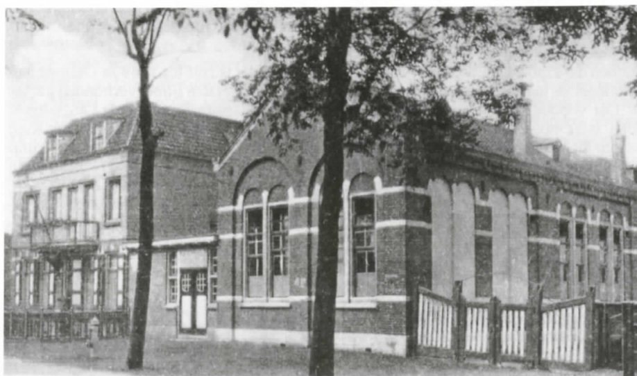
In het gebouw van de 'School met den Bijbel', vanaf 1951 'Prinses Ireneschool' genaamd, vinden we thans het sociaal-culturele wijkcentrum 'De Schakel'. De dienstwoning aan de Ouddiemerlaan 49, inmiddels voorzien van een verdieping, staat er nog steeds (prent-briefkaart coll. Margreet van Loenen).
