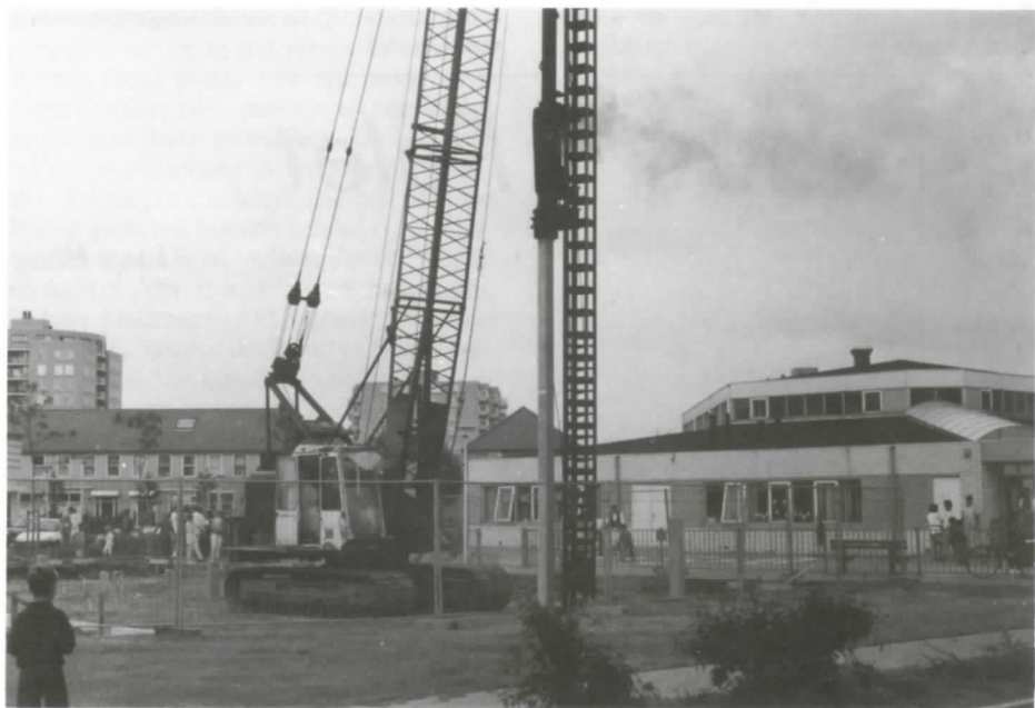
In het voorjaar van 1994 werd 't Palet' uitgebreid. De palen voor 't Atelier' gaan hier de grond in (foto Jaap Haag).
