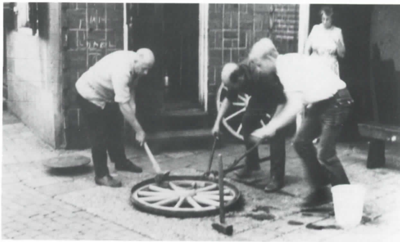
Het omleggen van een wielband door Arie van Dijk, zijn broer Gerrit, Dirk van der Velde (van links naar rechts). Arie's zuster Wil kijkt toe (foto A. van Dijk).
