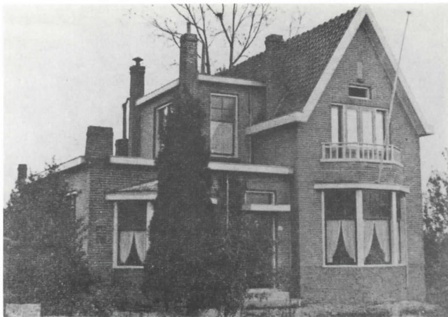
Afb. 10 - Het woonhuis van kassier W. van Sijtveld annex bankgebouw aan de Ouderkerkerlaan 57
