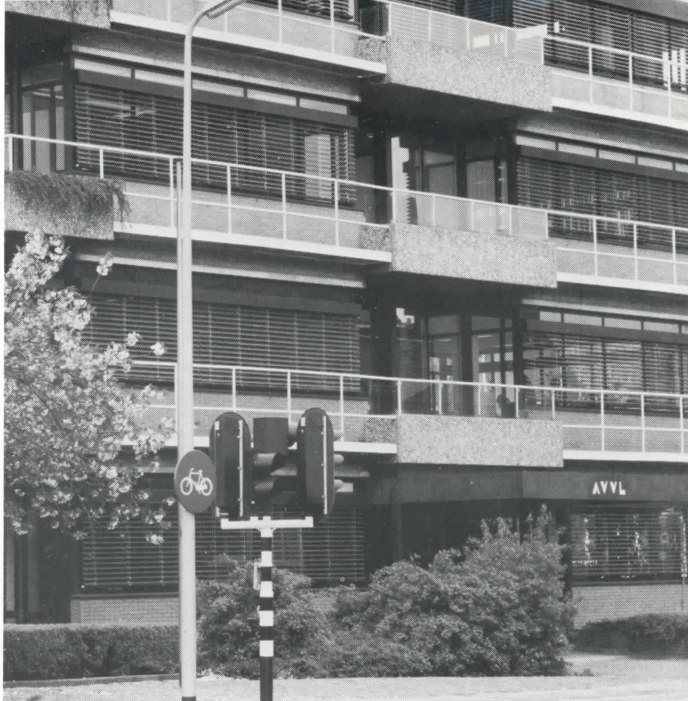
Het nieuwe hoofdkantoor van de AVVL kon in juni 1976 in gebruik worden genomen
