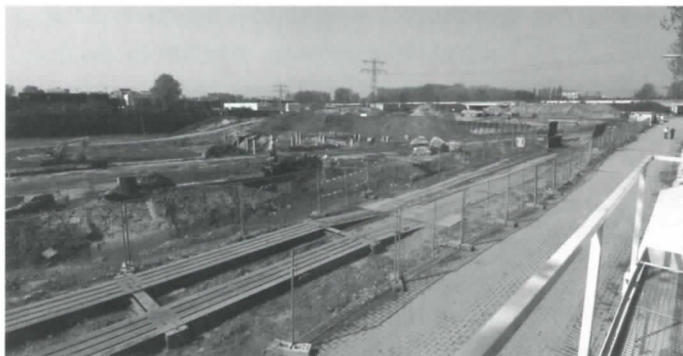
De saneringswerkzaamheden op de Sniep in volle gang (foto Wiard Krook, mei 2006).
