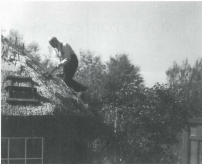
Gerrit Portengen in 1979 aan het rietdekken.
