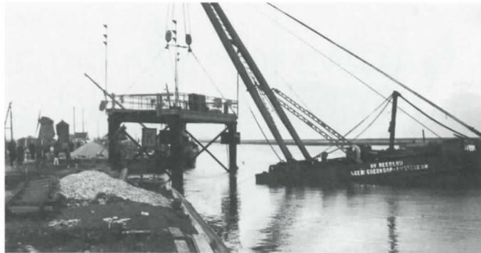
De veerwagen wordt door een drijvende kraan van de Amsterdamse firma N.V. Reederij v/h Gebr. Goedkoop op de railbaan gezet (foto fam. Heek-v.d. Meent).
