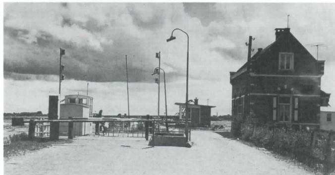
De veerwagen aan de Overdiemerweg ligt in de ponthaven. De trapgevel van het pontwachtershuis is hier verdwenen omdat Rijkswaterstaat op de onderhoudskosten van de dienstwoning wilde besparen (foto coll. HKD).
