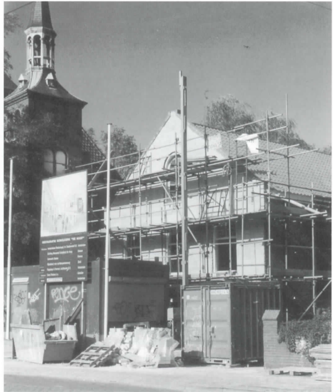
De restauratie van "De Hoop" in volle gang in de zomer van 1997 (foto Jaap Haag).
