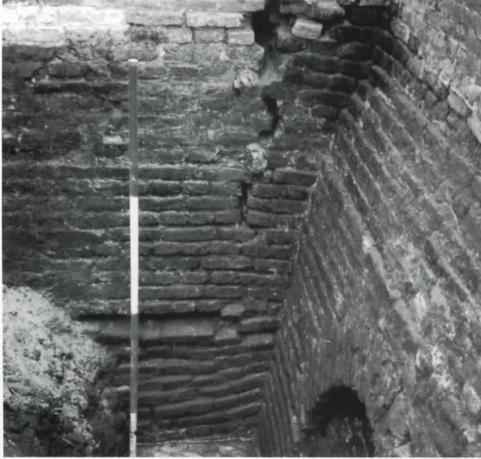
Een gedeelte van de binnenzijde van de door de AWN opgegraven funderingsmuren van de toren van de Mariakerk. Duidelijk waarneembaar is de grote scheur in de fundering, veroorzaakt door het verzakken van de toren (foto Wiard Krook, 1989).
