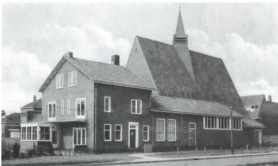
De gereformeerde kerk aan de Schoolstraat, sinds 1968 "Bethlehemkerk" en nu "Ontmoetingskerk" is gebouwd naar een ontwerp van de Amsterdamse School-architect B.T. Boeyinga. In zijn eenvoud toch een opmerkelijk karakteristiek gebouw (prentbriefkaart in 1940 uitgegeven door Diemer Boekhandel C. Smit Jzn., Diemen).
