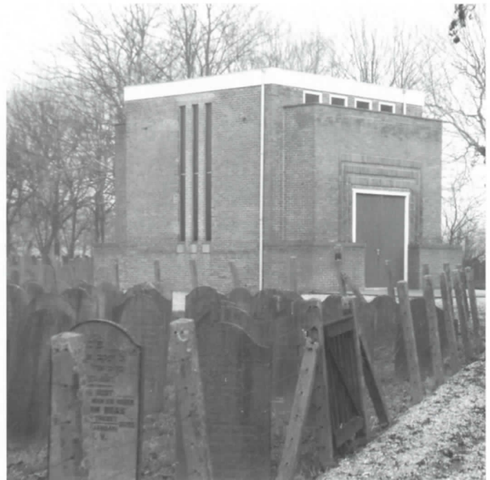
Het metaarhuisje (reinigingshuis) op de Diemense joodse begraafplaats. Het gebouw, door Harry Elte in expressionistische stijl ontworpen is thans als monument beschermd. De Diemense begraafplaats gold als een begraafplaats voor de armere joden. Wie zich geen steen kon veroorloven, zorgde voor een grafteken van hout (foto Jaap Haag 1998).
