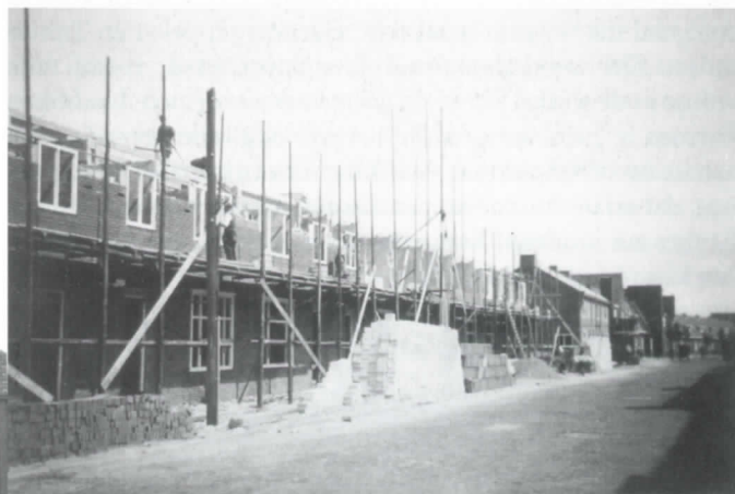
De bouw van woonhuizen aan de Burgemeester De Kievietstraat
