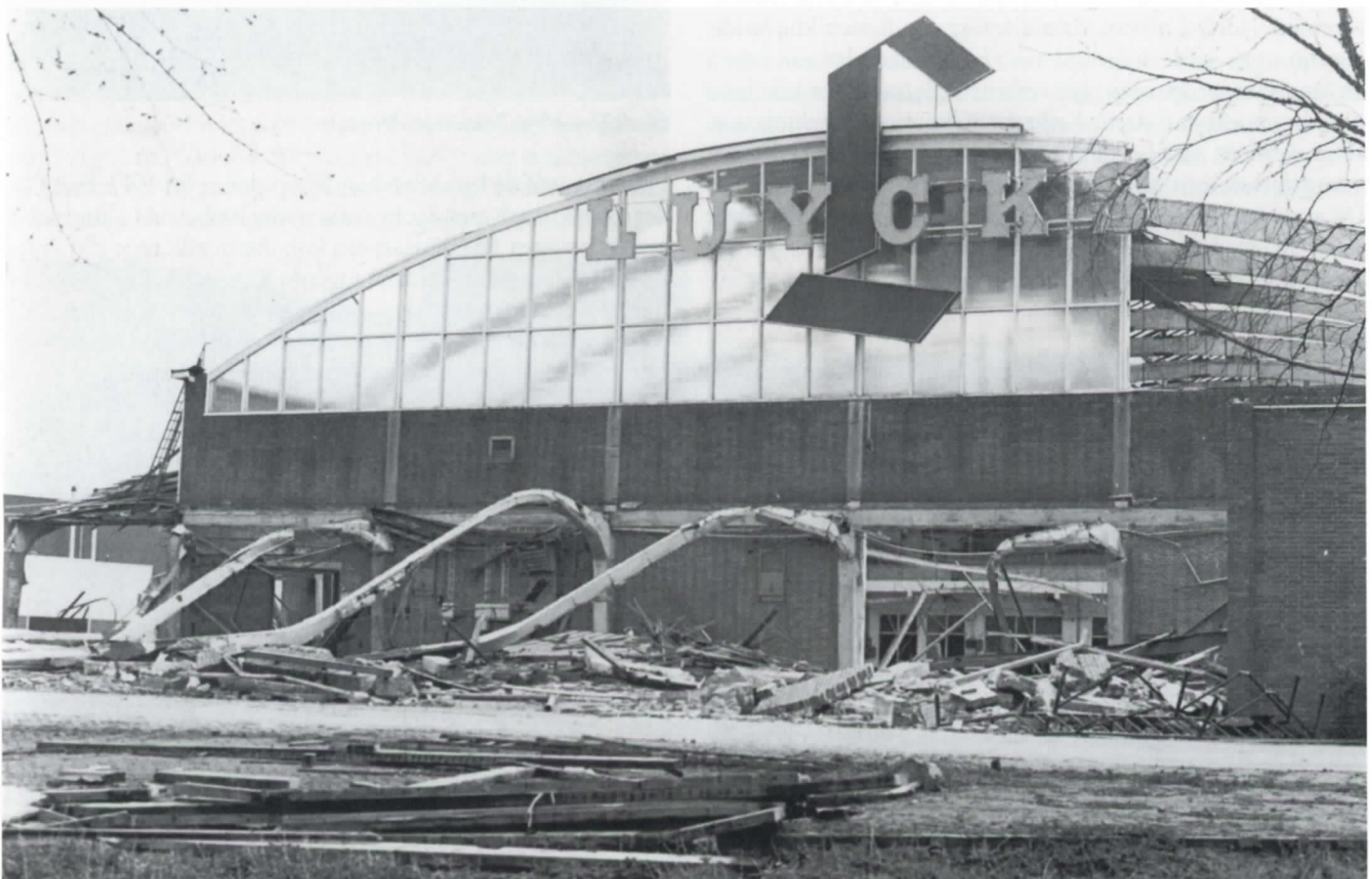
De sloop van het Luycks-complex in 1988 (foto Gerrit Hols)
