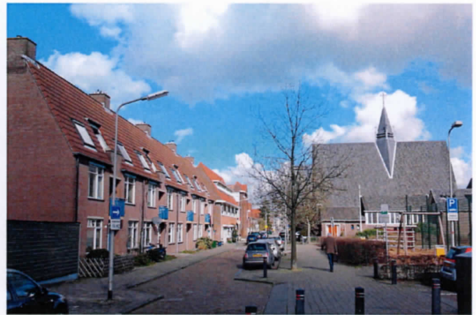
De in het midden van de jaren '80 gerealiseerde dorpsvernieuwing aan het begin van de Schoolstraat (foto Jaap Haag)
