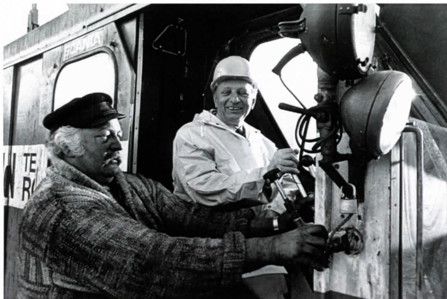
Links en onder: op 1 december 1983 sloeg Alfons Ruitenbeek, de Diemense wethouder van Economische Zaken, officieel de eerste paal voor de bouw van een meubelzaak aan de Meubelboulevard op 'De Sniep' (foto's Gerrit Hols)
