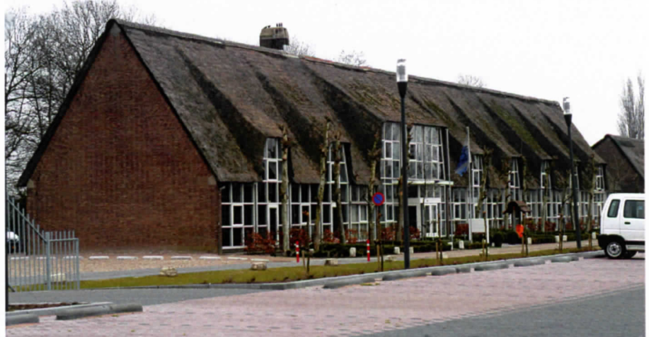
De ruime, met riet gedekte, grote werkschuur, zoals in 1957 werd ontworpen door architect Frank van Klingeren. Geheel rechts staat de kleine werkschuur (foto 2009, Wiard Krook)
