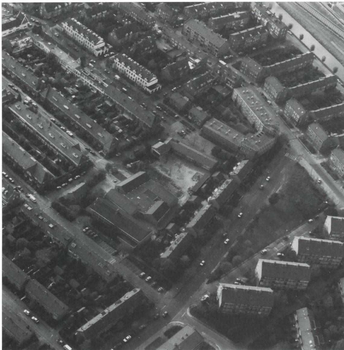
Luchtfoto van een gedeelte van Diemen-Centrum. Rechts midden het markante gebouw van 'Probezo' op de hoek van de Arent Krijtsstraat en het Wilhelminaplantsoen (foto Jan Sikking).
