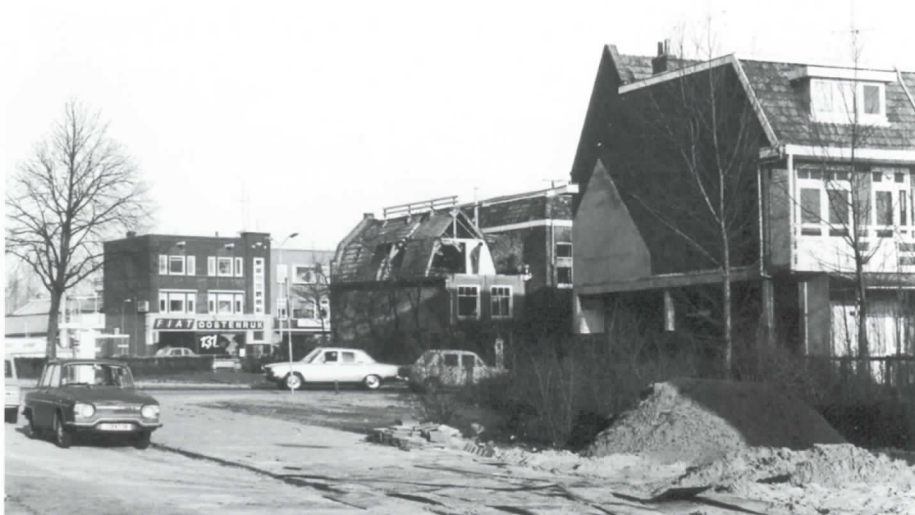
De afbraak rond de Ouderkerkerlaan. Op de voorgrond de achterkant van het huis in de Weesperstraat waar de familie Bosman de bovenverdieping bewoonde. Aan de overkant aan de Prins Hendrikkade wordt het pand met de winkel van Jan Rentzenbrink gesloopt.
