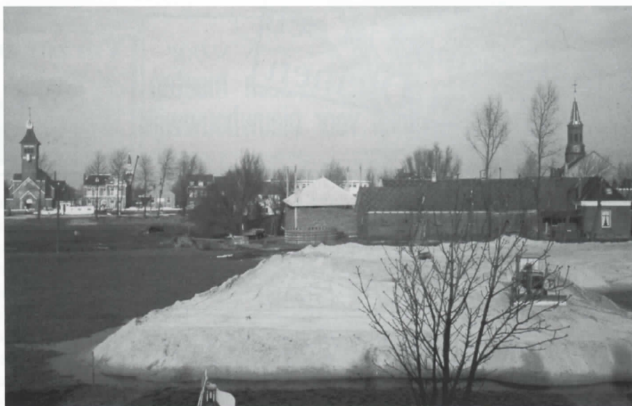
Als eerste werd het terrein naast boerderij 'Rundervreugd' van J. Staal opgespoten. Daar verschenen de werkketen van de Ballast Mij. Op de achtergrond de Hartveldseweg met de St. Petrus' Bandenkerk en rechts de toren van de Hervormde kerk bij de Diemerbrug (foto W. Martens).
