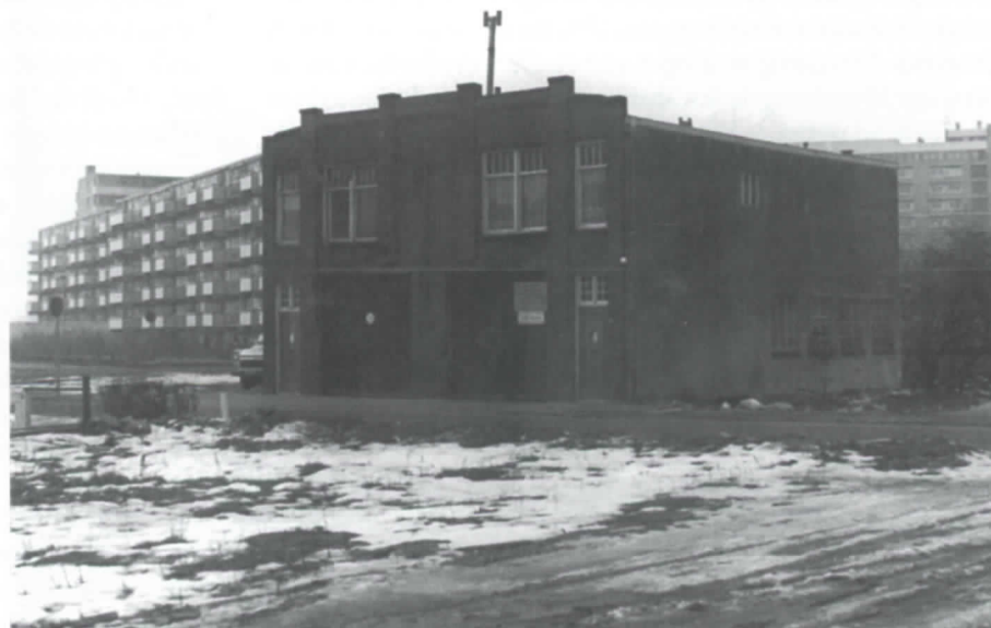
De restanten van de bebouwing aan de Ouderkerkerlaan. Op de achtergrond de flats van Beukenhorst.
