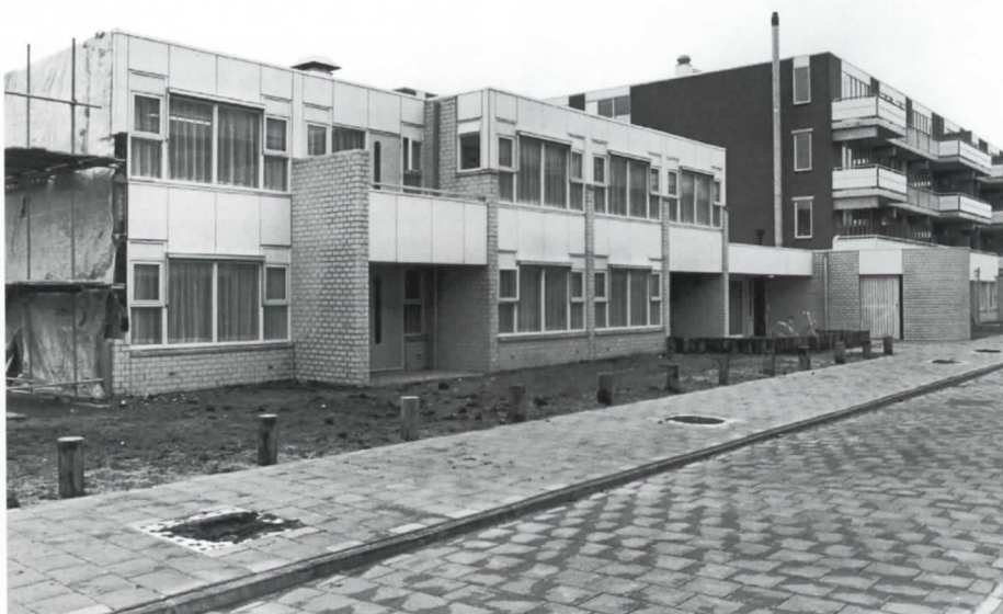
Het Sociaal Medisch Centrum Diemen-Zuid in aanbouw (foto Gerrit Hols).
