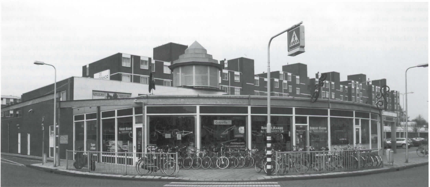
Het verbouwde "Winkelcentrum Kruidenhof" in Diemen-Zuid met rechts het "Tapas-restaurant Casa Sanas" (2008).
