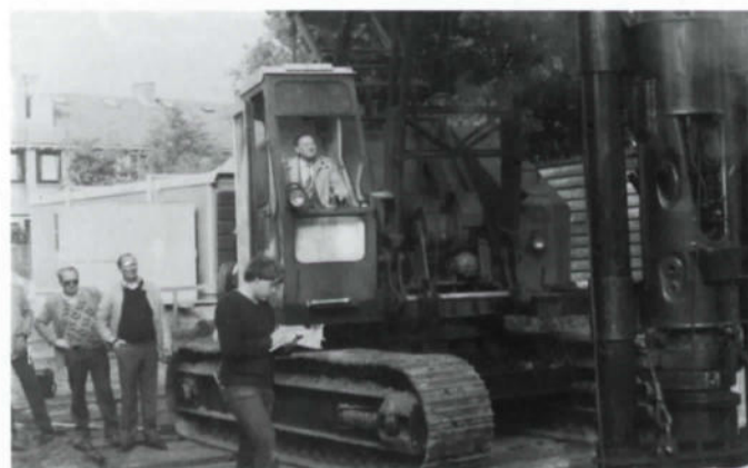
Het slaan van de eerste paal voor het nieuw te bouwen restaurant " Ling Hong " aan de Ouddiemerlaan 15 in 1984.
