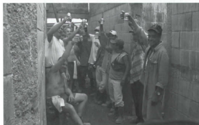
In Nandaime wordt sinds augustus 2007 hard gewerkt aan de bouw van de nieuwe EHBO-post op het terrein van het ziekenhuis. Aannemer Roger Bustillo werkt met lokaal personeel en een kleine werkploeg van de "Stichting Herstelling Den Helder" aan dit nieuwe project dat wordt gefinancierd door de VIVOS, de inwoners en het gemeentebestuur van Diemen, en het ministerie van Buitenlandse Zaken. De middelste foto toont het bereiken van het hoogste punt (foto's Peter Prins).
