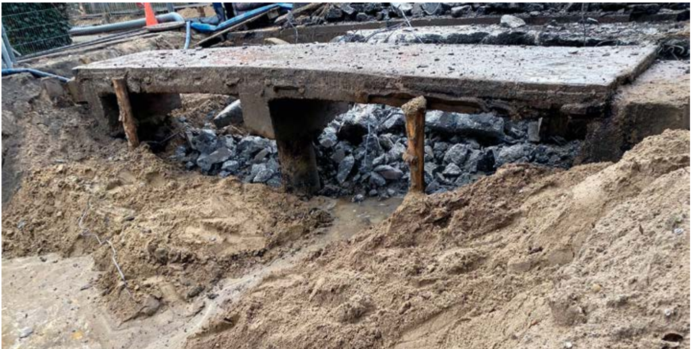
Het uitgezaagde wegdeel op zijn oorspronkelijke locatie op de Burgemeester Van Tienenweg, bij de Gerard Burghoutweg. Hier staat de weg nog met drie betonopzetters op drie ingehaide houten palen. (fotografie AW infrabouw, Lisse, 2022)
