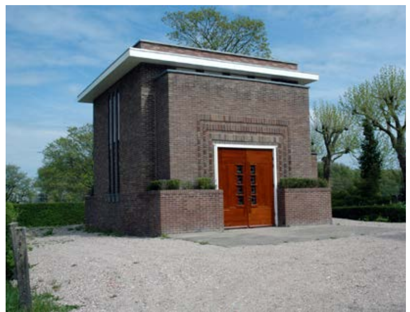
Het in 1932 gebouwde metaheer- of reinigingshuis op de Nederlands-Israëlitische begraafplaats te Diemen werd ontworpen door architect Harry Elte Phzn. (1880-1944) en gebouwd door de Diemense aannemer Jan Goedhart (foto 2022, Wiard Krook)
