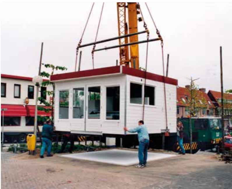
In 1996 werd een nieuwe kraam geplaatst aan de Hartveldseweg. De kraam was gemaakt door aannemer Chris Vijn en werd door de firma Koninklijke Saan deskundig op zijn plaats gezet
