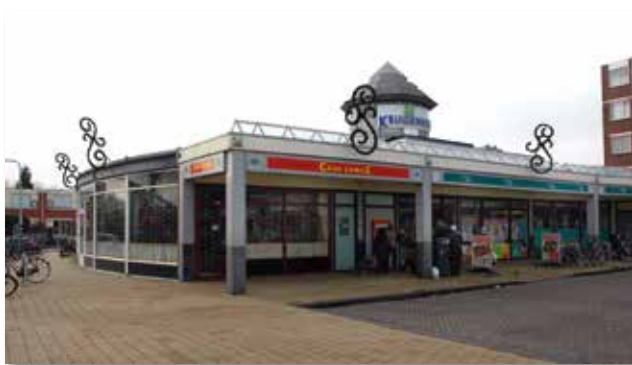
De Super de Boer-vestiging in het 'Winkelcentrum Kruidenhof'. In de ronde aanbouw zit nog de rijwielzaak (foto 2012, Wiard Krook)
