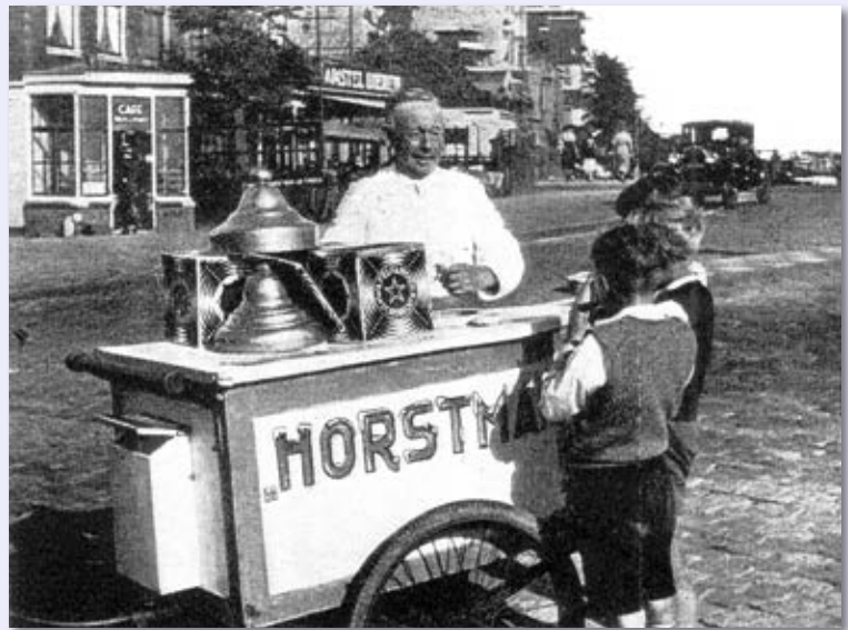
S.D.A.P.-gemeenteraadslid en locoburgemeester voor één dag Horstman aan het werk op de Hartveldseweg nabij de Hartveldsebrug (Het Leven, 3 september 1938)
