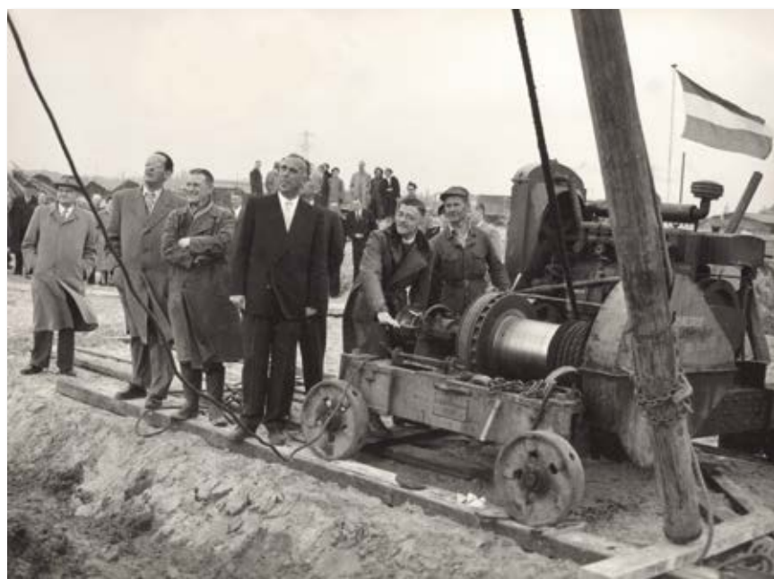
Burgemeester Strumphler Tideman slaat op 19 april 1957 de eerste paal voor het gebouw van Dagra N.V. op het industrieterrein De Sniep (coll. HKD)
