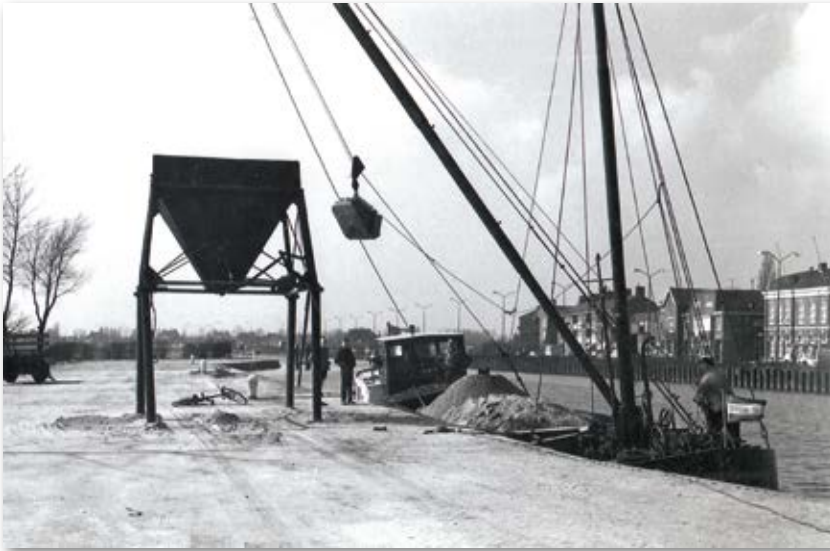
In de jaren veertig en vijftig van de vorige eeuw werd zand en grind voor de ophoging van onder andere de wegen aangevoerd met binnenschepen. Vanaf de Loswal reden de vrachtauto's af en aan over de Diemerbrug richting bouwplaatsen rond het Wilhelminaplantsoen en de Koninginnebuurt. De aanvoer van zand voor de Harmonielaan gebeurde noodgedwongen via het Merwedekanaal (coll. HKD)
