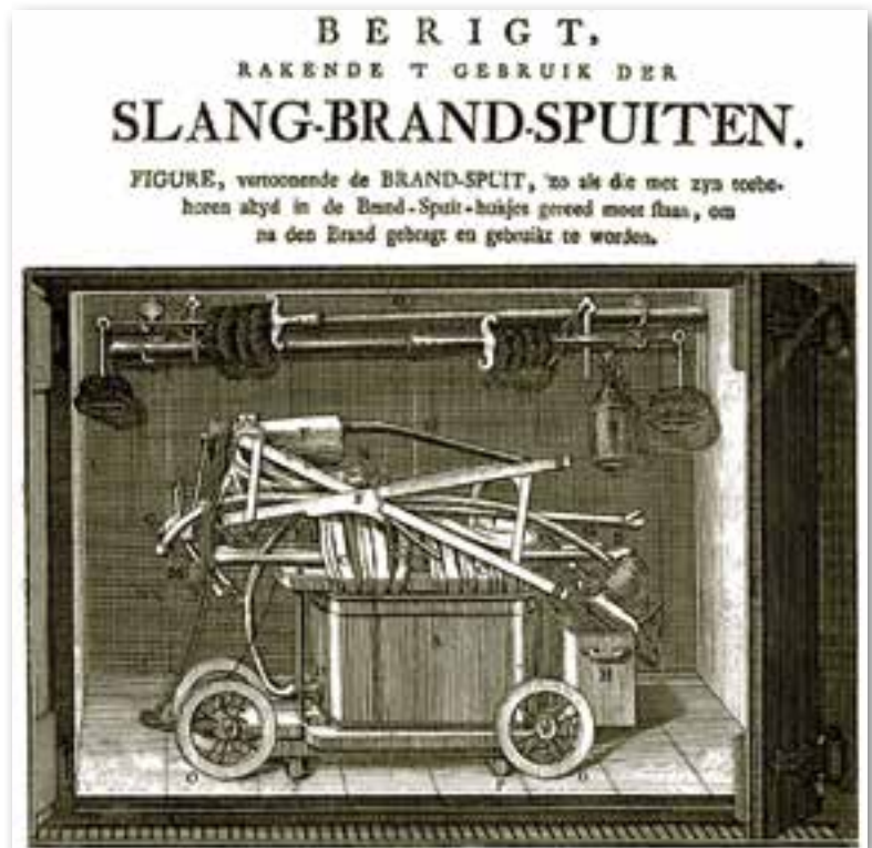
Een slangenbrandspuit in een huisje, volgens de richtlijnen van de firma Van der Heijden voor het onderbrengen van de slangenbrandspuit. In de praktijk had het brandspuithuisje deuren in de kopvel (archief Nederlands Brandweer Documentatie Centrum)
