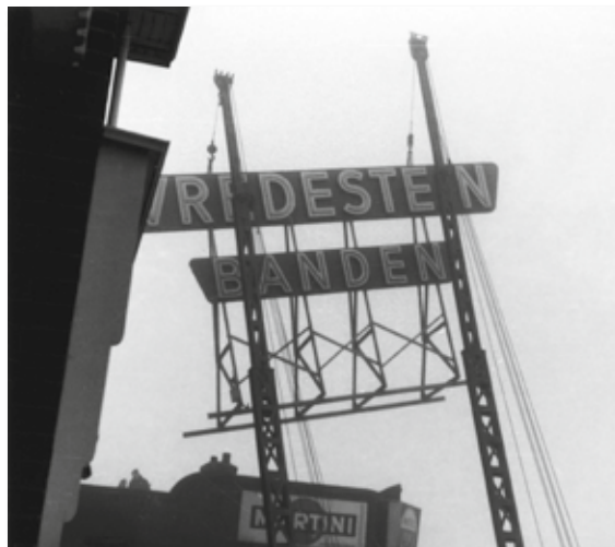
De onttakeling van de enorme lichtreclamestellige van Vredestein, die op het dak stond en jarenlang een bakken was langs de rijksweg. (foto coll. Wil Vijn-Aan de Stegge)
