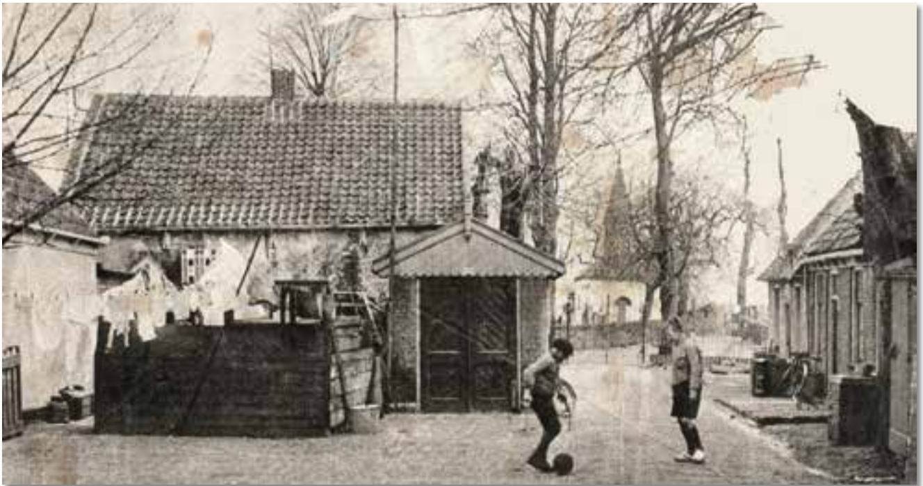
De houten wanden van brandspuithuisjes werden later in baksteen uitgevoerd, zoals bij dit huisje in Oud Diemen (coll. HKD)
