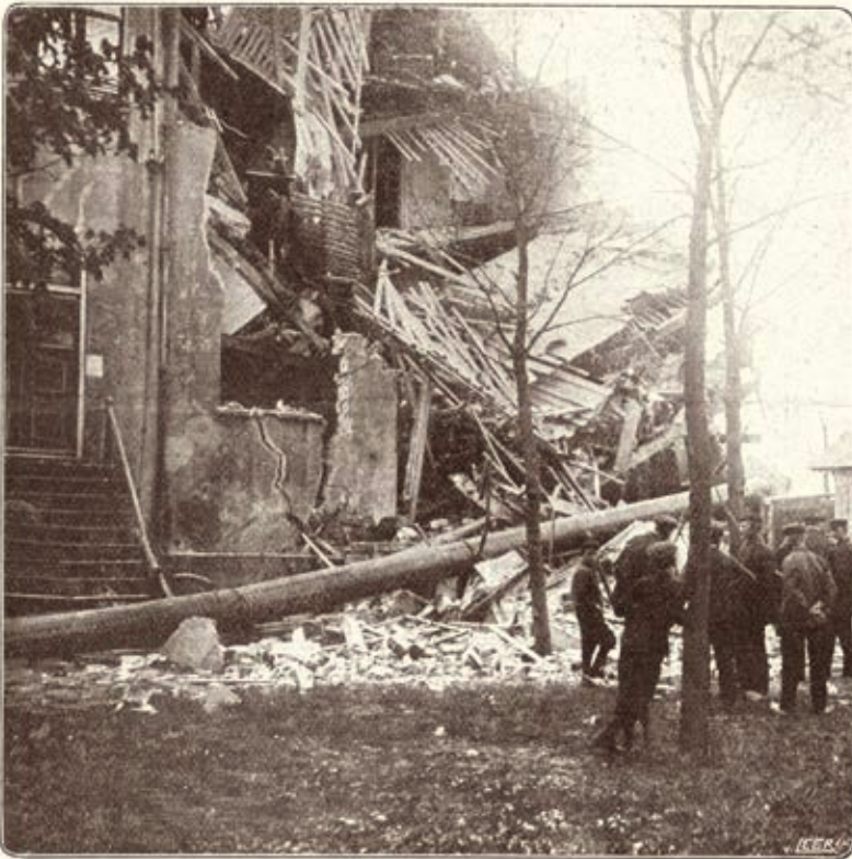
Het z.g. „Zwitserse Hotel“ te Diemen ingestort. In 1883 gebouwd met het oog op de in dat jaar gehouden internationale tentoonstelling, veranderde het herhaaldelijk van bestemming en vertoonde het reeds sedert verscheidene jaren teekenen van verval; de verschijnselen werden in den laatsten tijd verontrustender, in den achtermuur kwamen groote scheuren en verleden week stortte het achtergedeelte plotseling met donderend geraas, over de helft van het perceel, ineem. Gelukkig wisten de bewoners zich nog bijtijds in veiligheid te brengen; later hadden nieuwe verzakkingen plaats. De linkerhelft van de achterzijde gaf een groote ruïne te aanschouwen: brokstukken van ijzeren balken, steenen, houtwerk, stukken van meubelen in een chaos dooreem.
