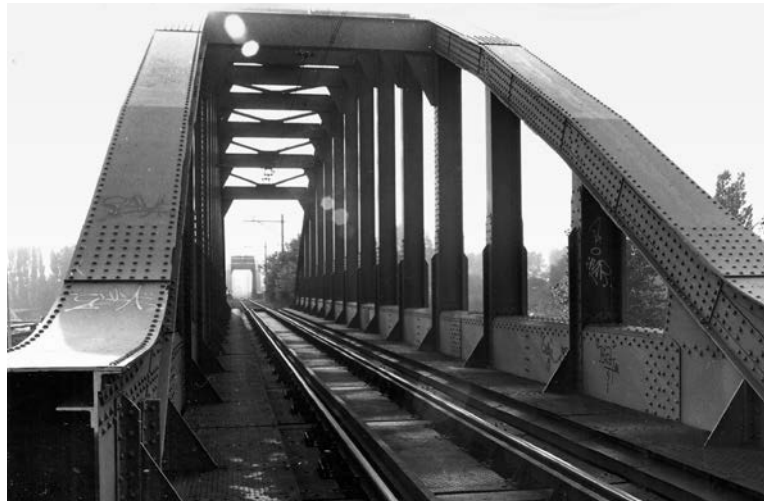
Diemen, oktober 1986. Brug van de RingSpoorbaan over de Muiderstraatweg richting Diemen-Zuid. (foto Willem J.A. Mol)
