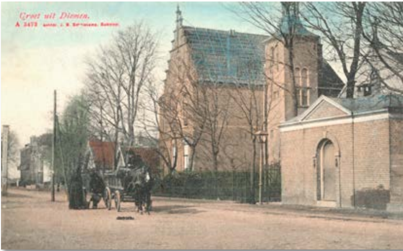
De Hartveldseweg met de pastorie bij de voormalige schuilkerk De Hoop, 1902. Het gebouwtje rechts op de voorgrond is het arrestantenlokaal. (prentbriefkaart J.W. Schalekamp, collectie HKD)
