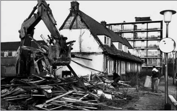
1985 - Sloop woningen aan de Ouddiemerlaan, Diemen Centrum
