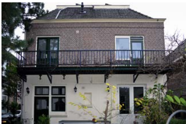
Afb. 3: Woning van het Hoofd der School – Ouddiemerlaan 49 –, zoals deze eruit ziet als men vanaf de achtertuin naar het huis kijkt. Duidelijk zichtbaar is dat er een verdieping op de woning is gezet. (foto: Jan Ronday)
