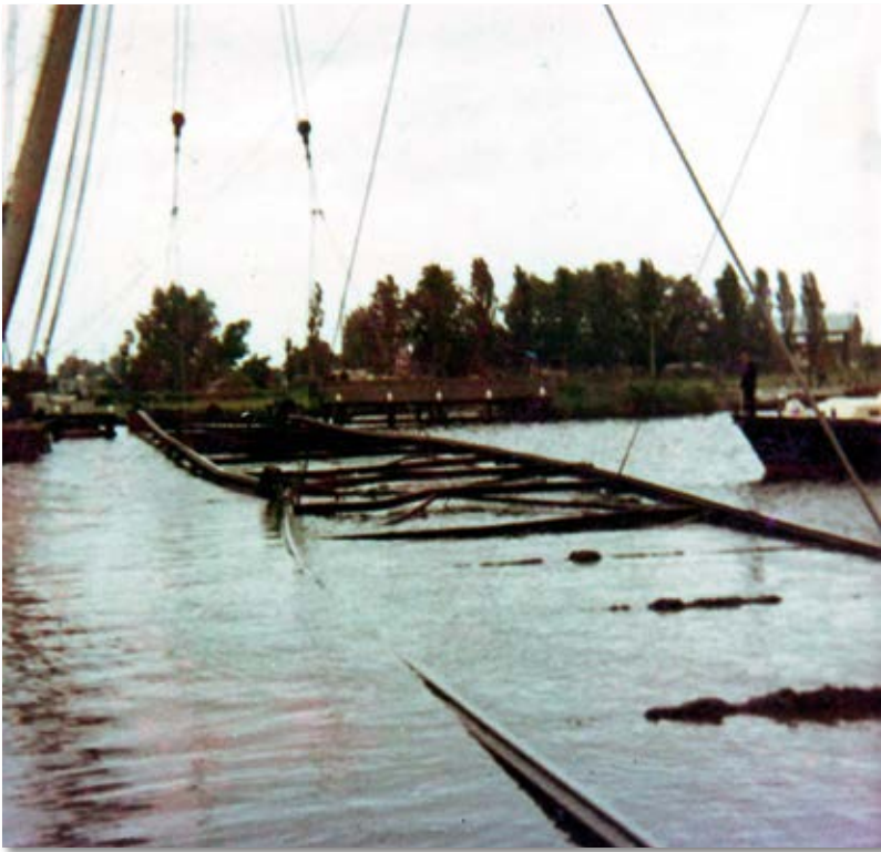
Figuur 5: De beschadigde rail van de veerwagen (±1967).
