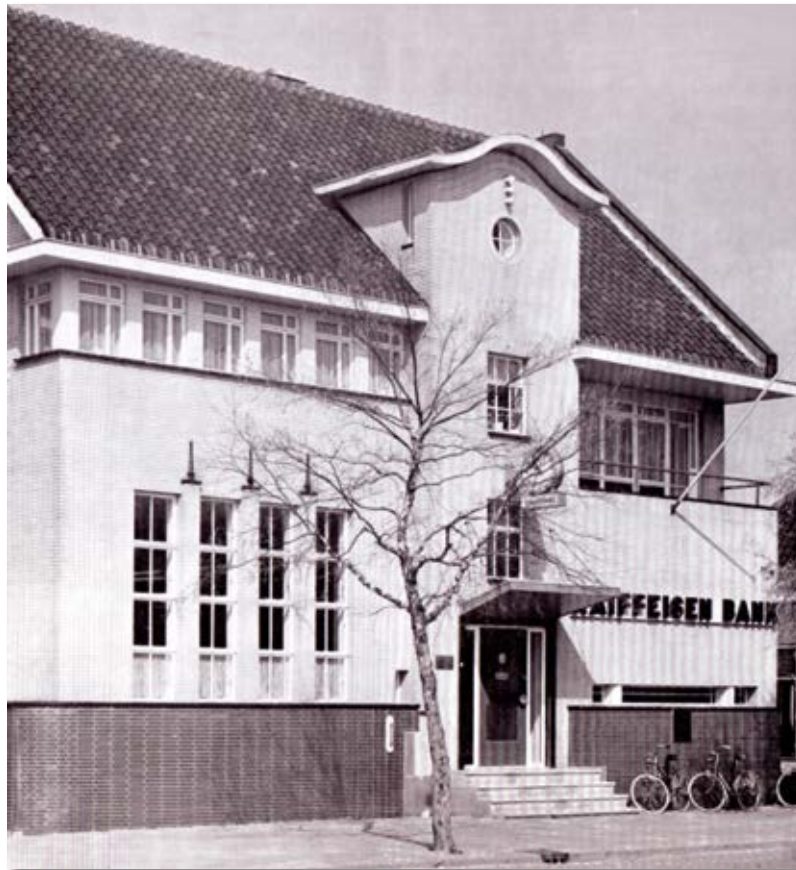
Het gebouw van de Raiffeisen bank aan de Ouddiemerlaan 25 in 1964. Klok aan de gevel met aanduiding Spaarbank (foto: Joh. van Wierst, collectie Rabobank).
