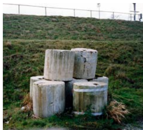
Een aantal van de betonnen wegversperringen die medio 1939 door het Nederlandse leger bij het spoorwegaaduct over de Muiderstraatweg werden geplaatst (foto Guus Kroon).
