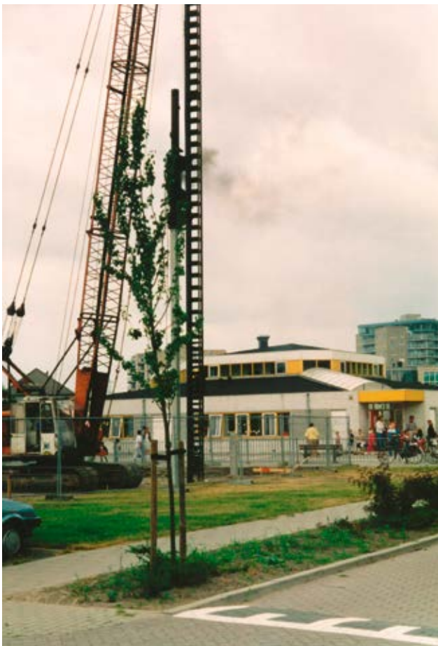
De eerste heipalen die in de zomer van 1994 voor de bouw van noodlokalen bij 't Palet de grond in gingen. (foto J. Haag)
