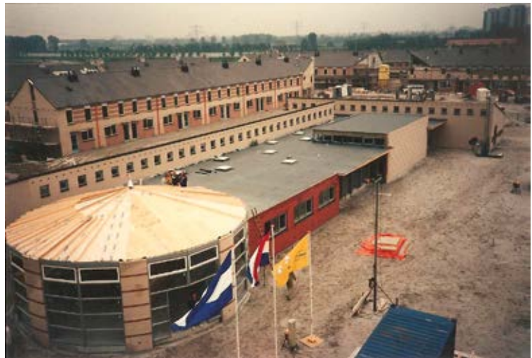
Het gebouw van De Duif aan de Schouw is in 1993 bijna klaar voor gebruik (foto H. Hogenaar).
