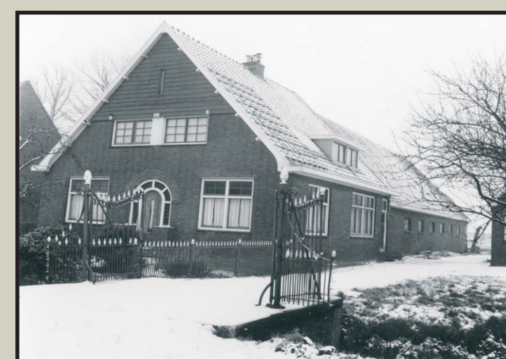
2. Boerderij De Stenen Kamer na de herbouw in 1935.
