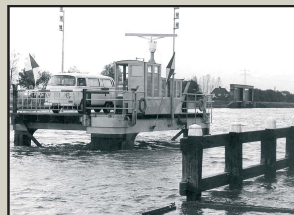
2. Rijdende veerpont met dieselmotor die in 1939 de met de hand bediende pont verving
