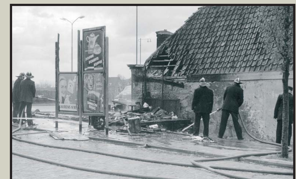
3. Bluswerkzaamheden na brand ten gevolge van een gasexplosie in de patatkraam op de hoek Nic. Lublinkstraat/Muiderstraatweg.
